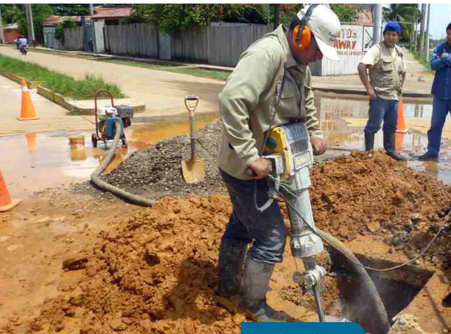
Reparación de Fugas
