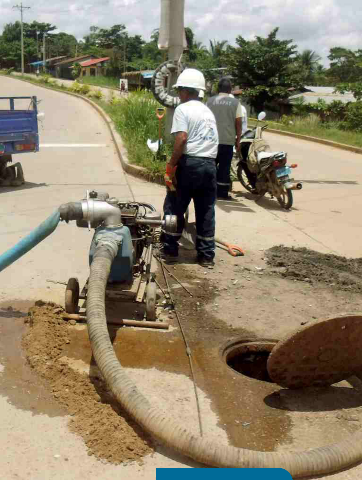
Limpeza de Buzones Colapsados por Mal Uso.
