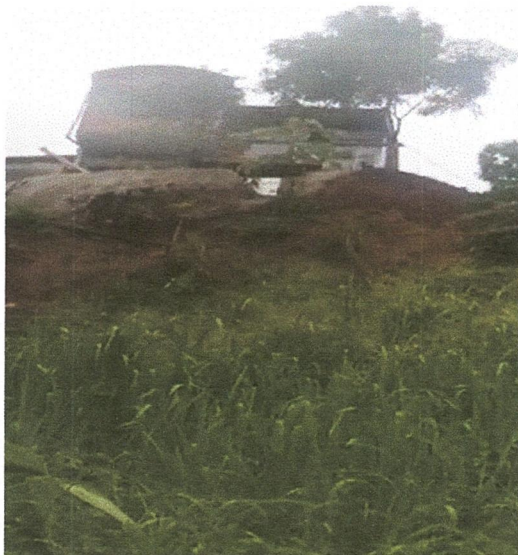
Talud en proceso de deslizamiento
