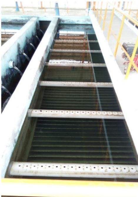
Decantación, se cuenta con 05 decantadores laminares que contienen pantallas de vinilona que incrementan la superficie de decantación permitiendo la deposición de las partículas en suspensión en las tolvas de almacenamiento de lodos, el agua decantada es recolectada a través de tubos perforados que descargan en un canal central que a su vez descarga en el canal de distribución de agua decantada.
