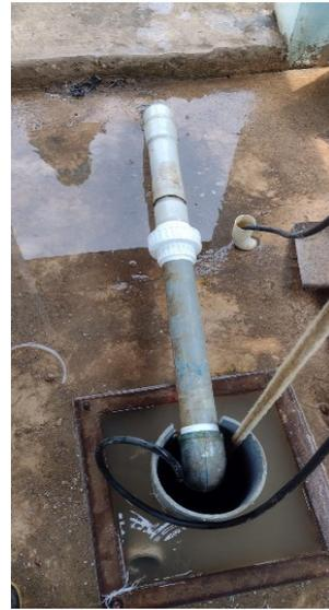
*Limpieza y lavado de la bomba sumergible del pozo N° 02*
