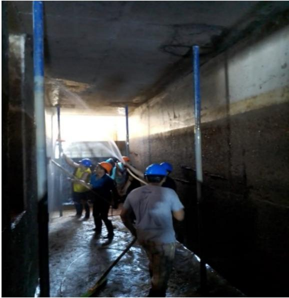
Lavado y enjuague del piso del Canal de Agua Decantada (CAD), 29/09/2023
