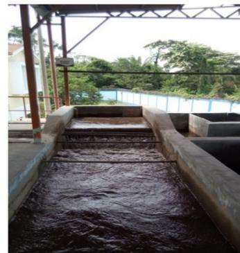
Floculación, consta de un floculador vertical de 05 tramos, con gradientes de velocidad diferentes, el agua floculada es distribuida a los decantadores a través de un canal de distribución.
