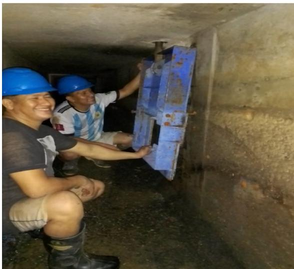
Retiro de válvula tipo compuerta del decantador N° 4 31/08/2023
