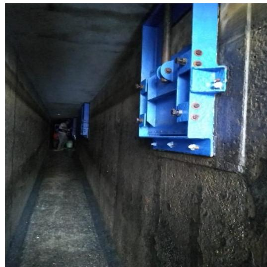
Instalación de válvula compuerta del decantador N° 3 – 31/08/2023
