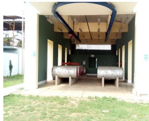
Cámara de contacto, el agua filtrada ingresa a la cámara de contacto, unidad que tiene la forma de serpentín con longitud total de 105 m en cuyo punto de ingreso se produce la adición de solución clorada produciéndose la mezcla y el contacto cloro - agua en un período aproximado de 30 minutos, descargando luego el agua en la cisterna de almacenamiento.
